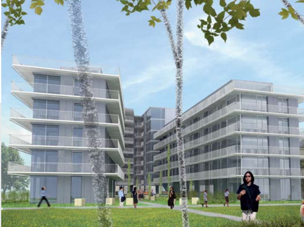
westliche Bauteile mit Hofsituation
