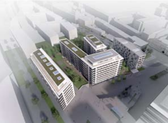
Bauplatz 5 von oben
